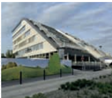
► Dock 01, 02, 03, Praha přístroje Mosaic, podlahové krabice, přípojnice Zucchini
