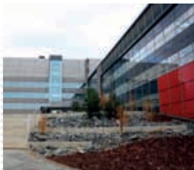
► Lékařská fakulta UP, Olomouc systém strukturované kabeláže LCS 2 , parapetní kanály DLP, přístroje Mosaic a Valena, jištění a spínání
