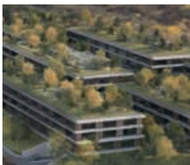
► ČSOB, Praha přípojnice Zucchini a Electrak, přístroje Valena Life, transformátory, POP-UP krabice, senzory CP electronics, zásuvkové bloky
