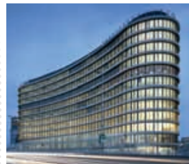
► Enterprise Office Center, Praha přístroje Mosaic a Niloe, podlahové krabice, přípojnice Zucchini
