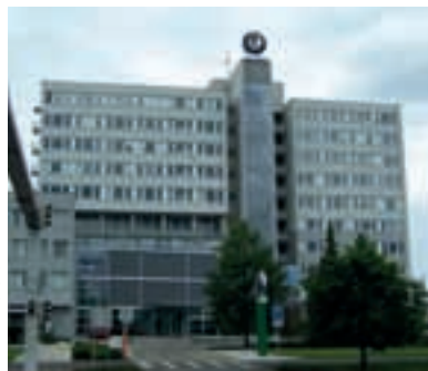
► Administrativní budova Škoda Auto, Mladá Boleslav parapetní kanály DLP, podlahové krabice, přístroje Mosaic
